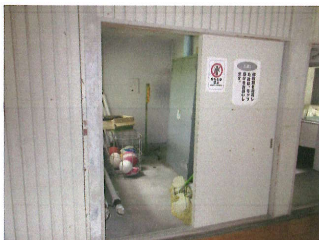
体育館内の倉庫
