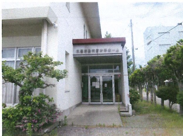
事務所棟出入口付近
