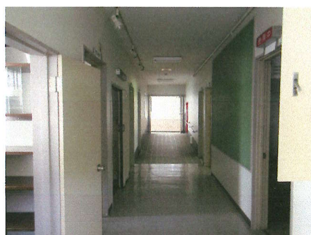
1F 廊下付近
