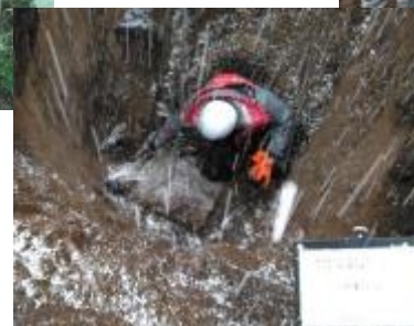
観測塔基礎工事
