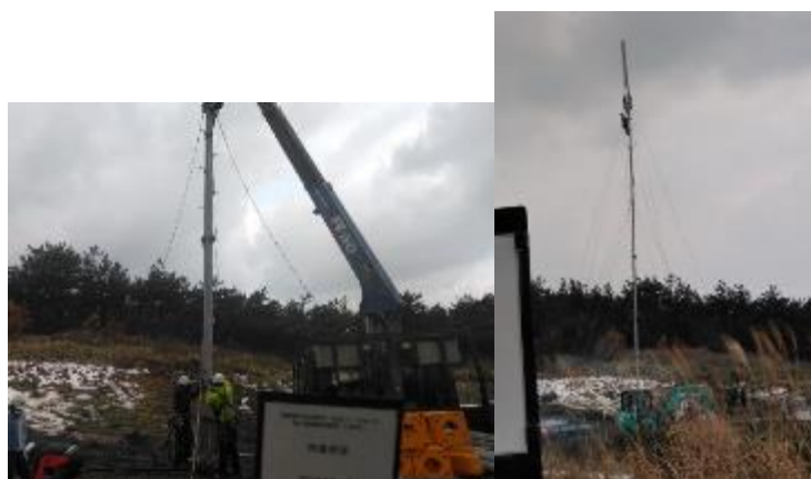
観測塔設置工事
