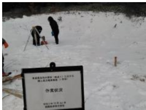
アンカー位置出し
