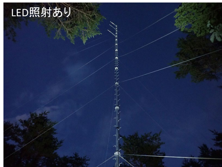
LEDライトによる照射状況
