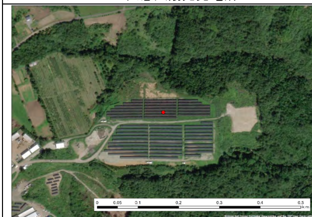
No. 05 久慈太陽光発電所
