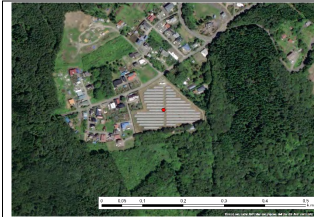
No. 07 トーエネック久慈発電所太陽光発電所
