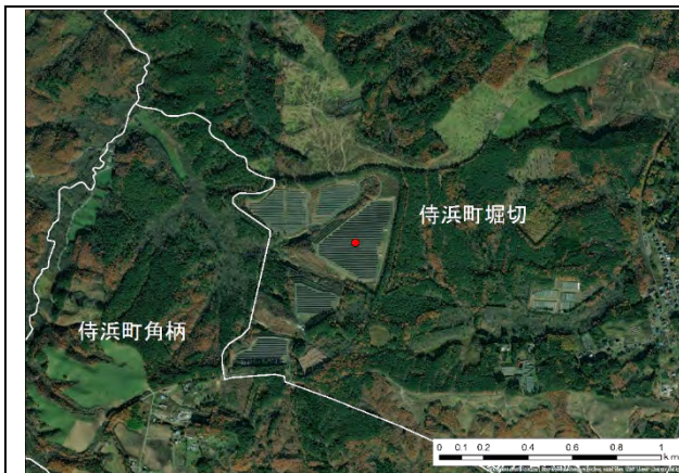
No. 01 久慈侍浜太陽光発電所
