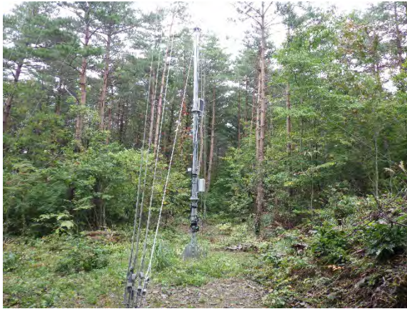
風況塔周辺環境
