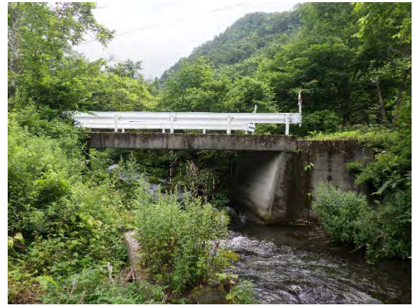
内間木洞周辺の橋梁
