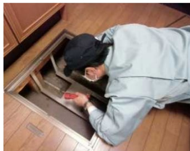
「土台・床組、基礎」調査の様子
