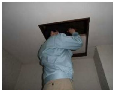
「小屋組・梁」調査の様子
