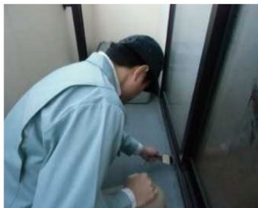
「外部（バルコニー）」調査の様子
