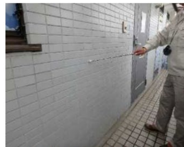
「外部（外壁）」調査の様子
