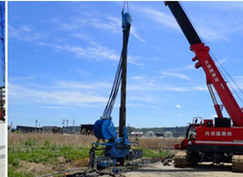
【鋼矢板の施工】
