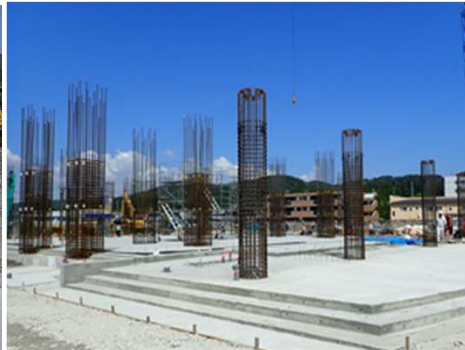
【地上部の骨組み工事の鉄筋組立て】
