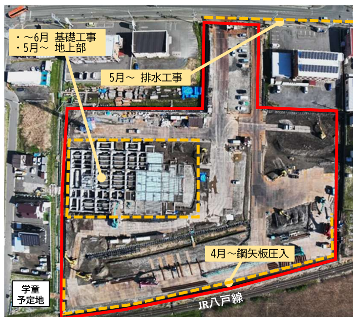
【現場状況（航空写真R8.4月末）】
