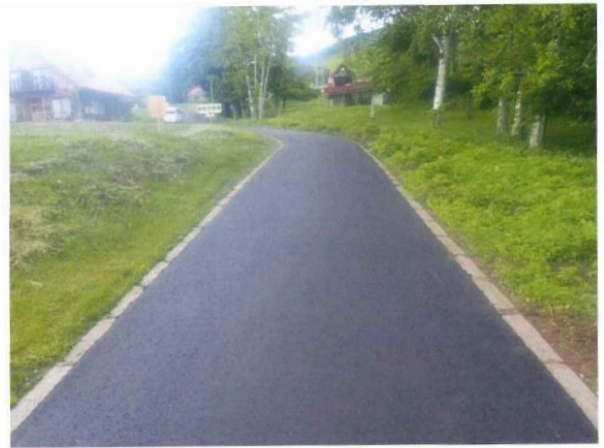
遊歩道舗装補修工 完 成
