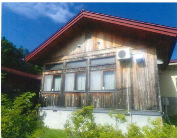
平庭山荘外壁保護剤塗布工 施工前
