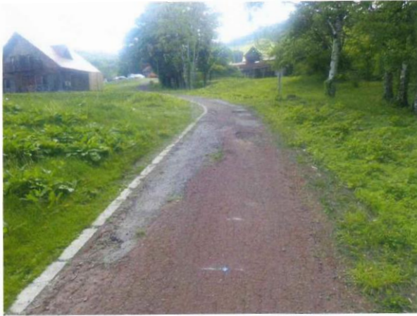
遊歩道舗装補修工 施工前
