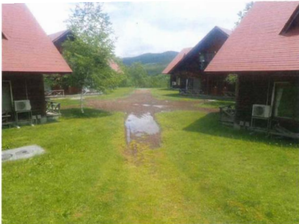
コテージ通路改修工 施工前
