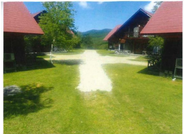
コテージ通路改修工 完 成
