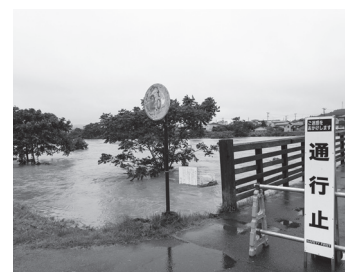
滝ダムの緊急放流により水位が上がった長内川（新街橋付近）
