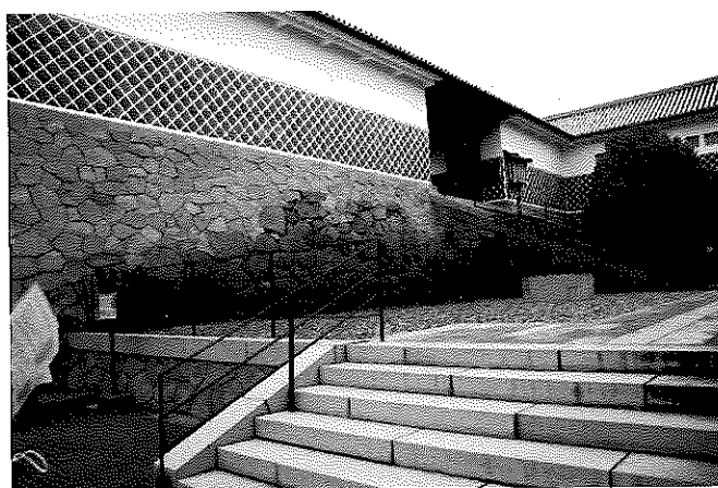
図 4 江戸時代建築された石積（穴太積み）
