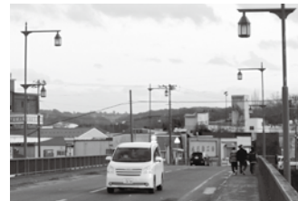
中心市街地と住宅地を結ぶ中の橋
