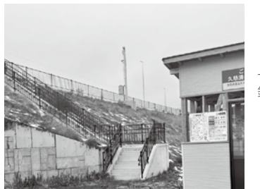
三陸沿岸道路への避難階段（新井田地区）垂直避難も要検討！
