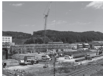
久慈湊小学校の工事現場
