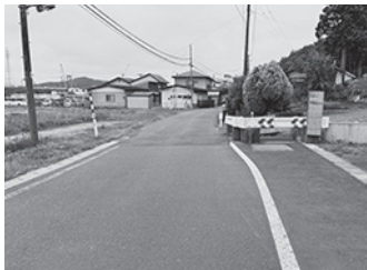
源道地区の未改良区間の状況
