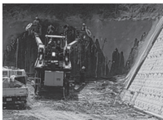
下平トンネルの工事風景
