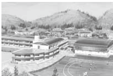
久慈小学校の完成予想図 鉄筋コンクリート3階建て 延べ床面積は7536.12㎡
