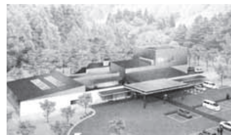
新火葬場の完成予想図。鉄筋コンクリート・一部鉄骨、2階建てで、延べ床面積は1642.49㎡。供用開始は7～9月の予定
