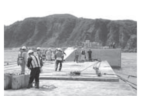
据え付け作業の様子
