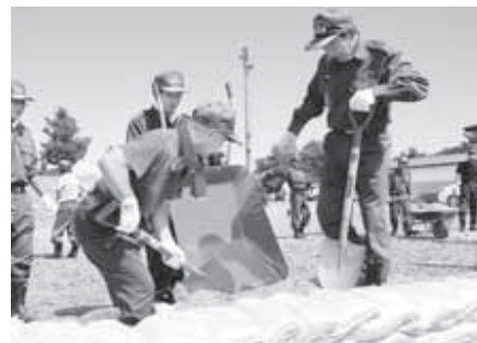
手際よく土のうを積み堤を作る消防団員
