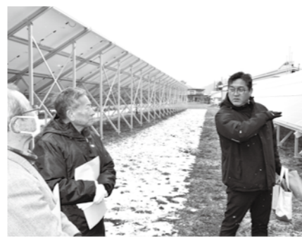
発電設備の説明を受ける参加者
